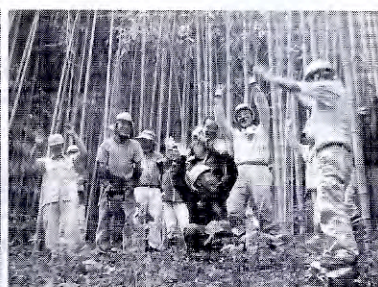
▲作業用道路が完成
